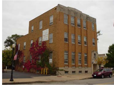
4949 Forest Ave – IL Bell Telephone +
